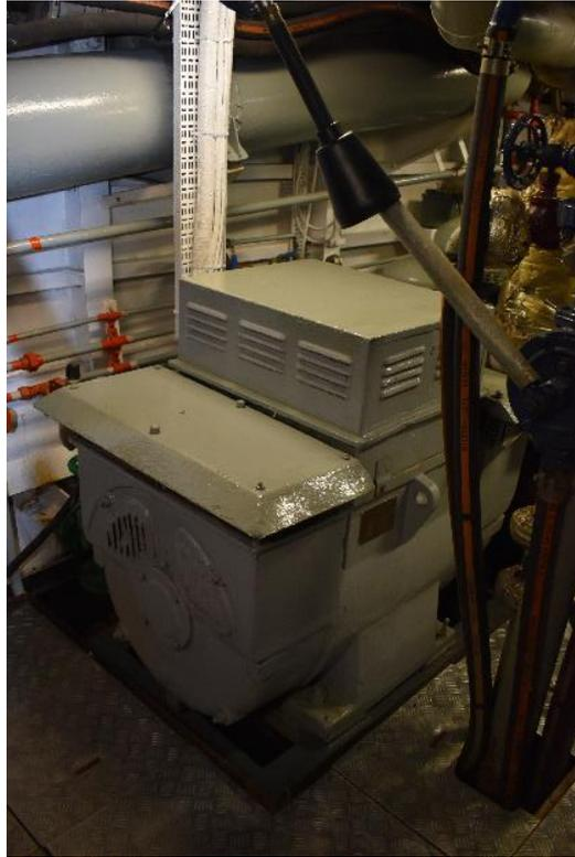
**Figura 3-9 Alternador 315-M acoplado al auxiliar de babor**
