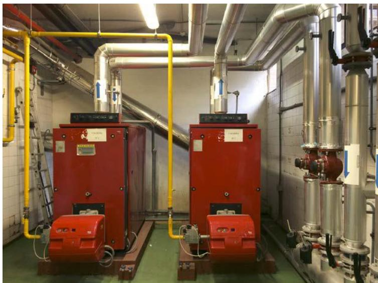
Figura 6-3 Detalle caldera Roca BT 450 y quemadores BAXI TECNO 50. [4]
