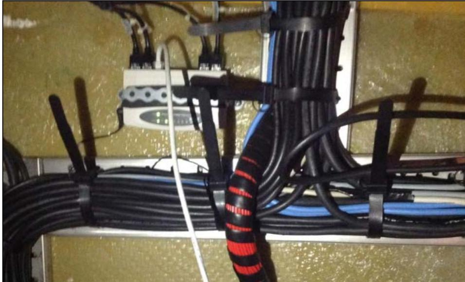
Ilustración 3-64 Concentrador de la red Navnet de las lanchas de instrucción (Tomado de [45]).
