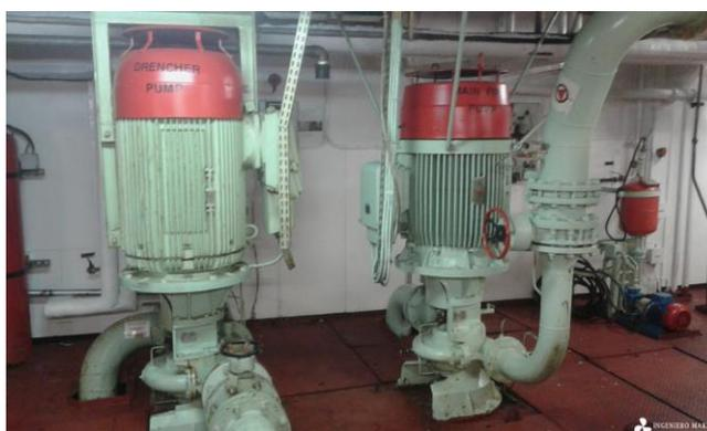
**Ilustración 2-8. Bomba fija del circuito contraincendios. [14]**
