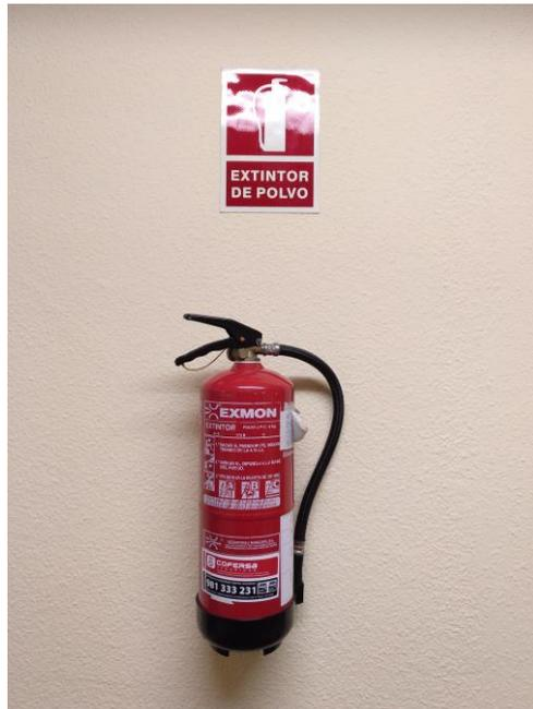
**Ilustración 2-14. Extintor de polvo seco.**
