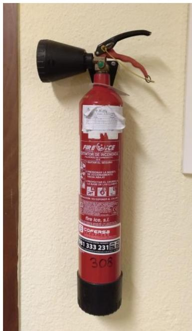
**Ilustración 2-13. Extintor de CO<sub>2</sub>.**
