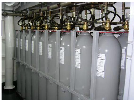
**Ilustración 2-12. Depósitos de CO<sub>2</sub>. [11]**
