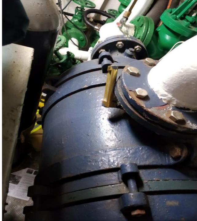
**Figura 3-14** Enfriador del servicio de refrigeración de agua dulce. Elaboración propia
