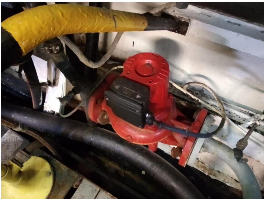
**Figura 3-15 Bomba del servicio de precalentamiento. Elaboración propia**
