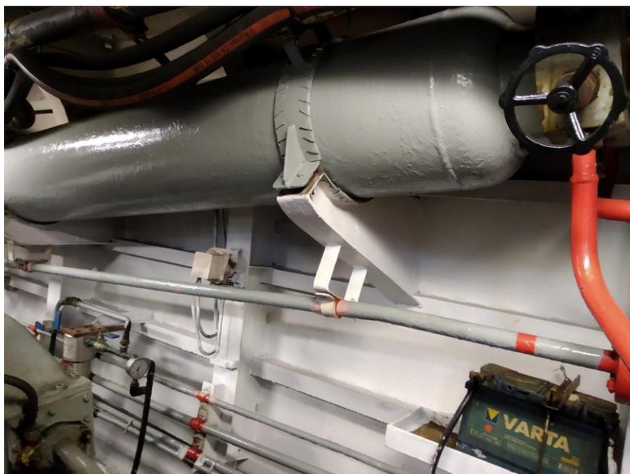
**Figura 3-11 Una de las botellas principales del servicio de aire de arranque. Elaboración propia**
