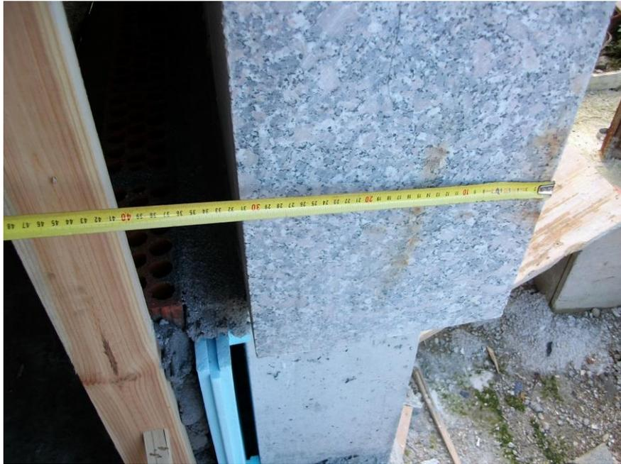
**Figura 4-10 Control espesores tabiquería [21]**
