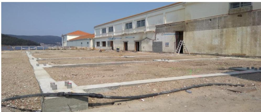
Imagen 3-7 Cimentación por micropilotes hormigonados in situ en la ENM (Fuente: [27])
