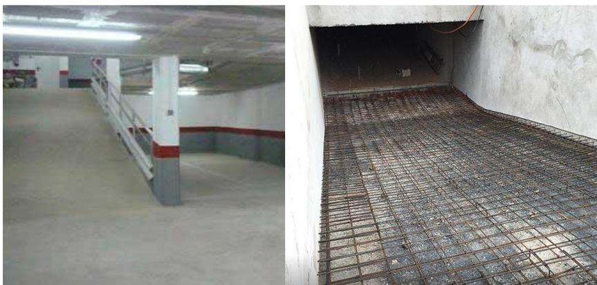
Imagen 4-17 Rampa de aparcamiento tipo losa maciza de hormigón armado (Fuente: [49])
