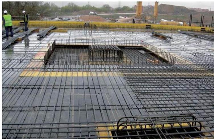
Imagen 4-16 Construcción de un forjado de losa maciza de hormigón armado (Fuente: [50])
