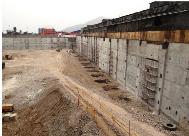
**Figura 2-4 Muro de pantalla (tomada de [12])**
