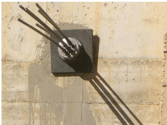
Figura 2-5 Anclaje de un muro de pantalla (tomada de [13])
