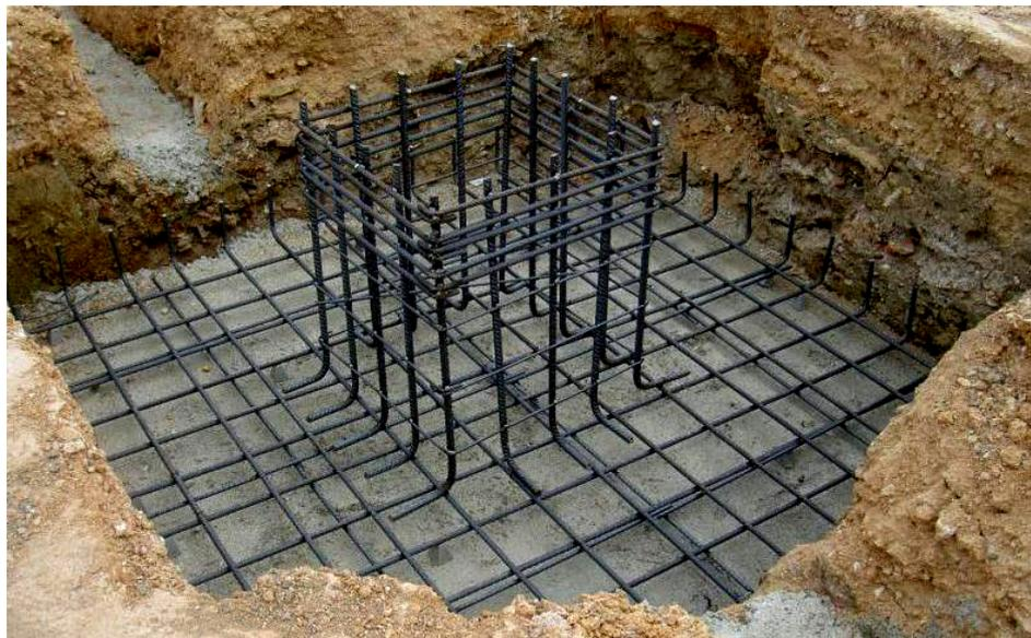
Figura 2-12 Zapata aislada de hormigón armado (tomada de [24])
