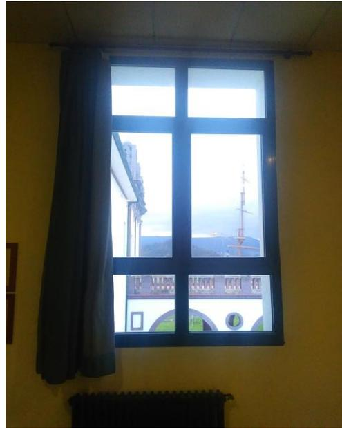
**Figura 0-4 Ventana climalit de doble cámara y marco de aluminio lacado**
