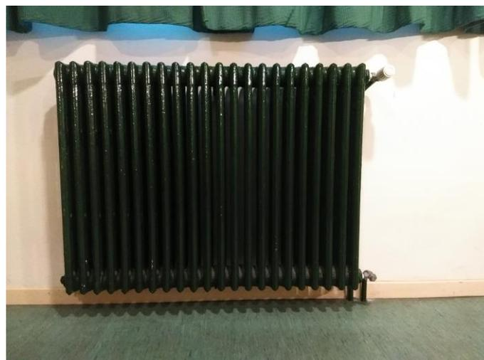
Figura 0-3 Radiador de doble tubo y agua caliente
