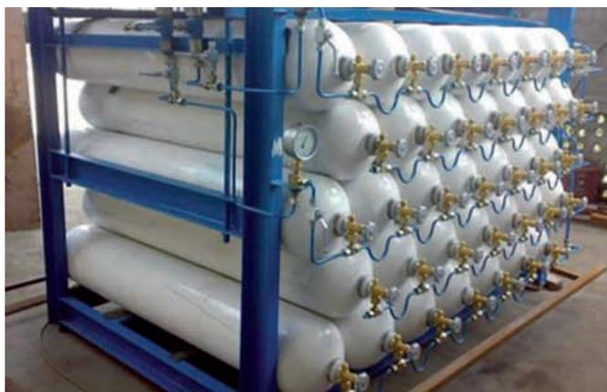
Figura 3-21 Tanque de almacenamiento de Gas Natural Comprimido [32]
