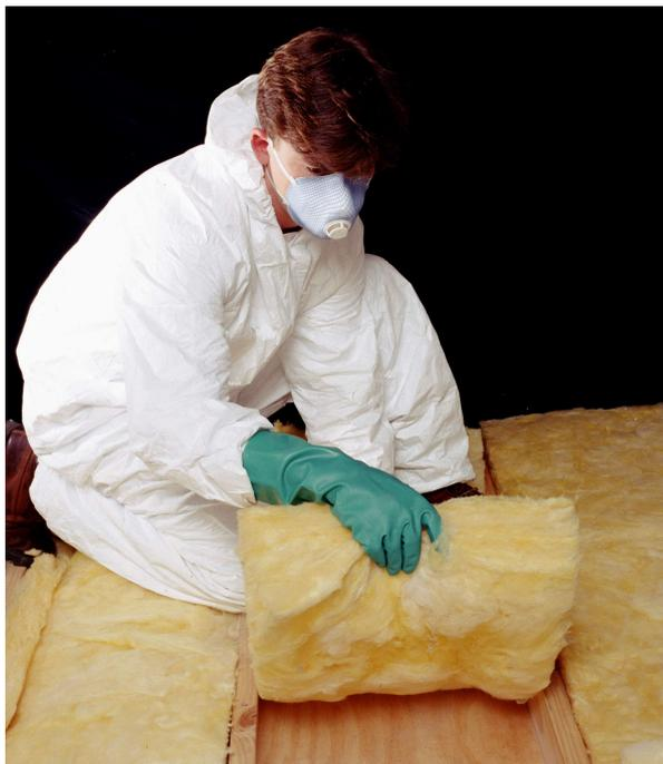
Figura 3.2 Instalación lana de vidrio [11]
