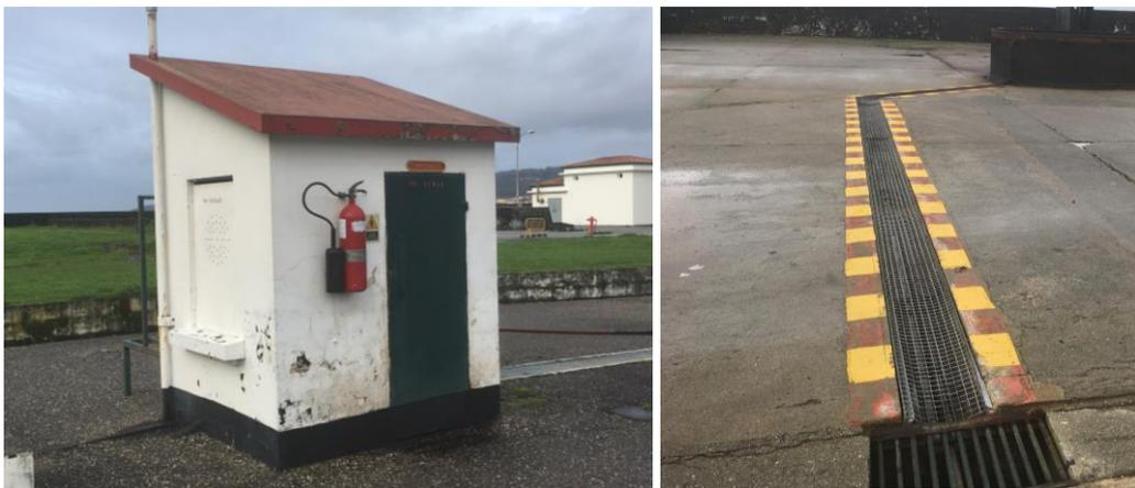
**Figura 3-11 Caseta de bombas y conductos de contraincendios**
