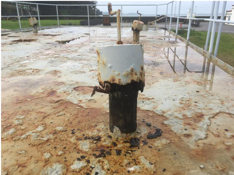
**Figura 3-15 Estado de las extracciones de humo del adiestrador contraincendios**
