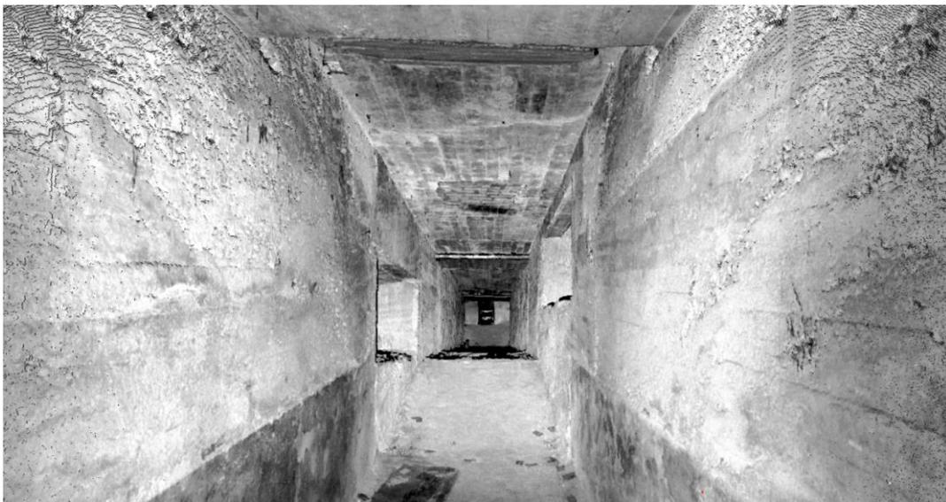
**Figura 4-2** Vista de la nube registrada y representada con atributos de intensidad
