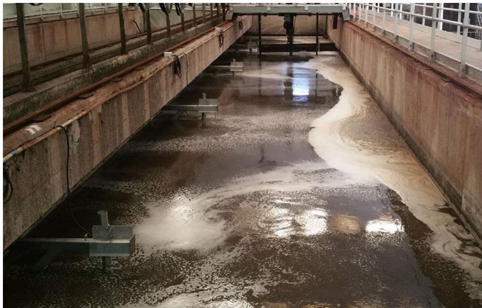
Figura 3-11 Desarenado y desengrasado [27]
