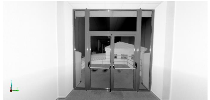
Figura 10 salida de emergencia superior
