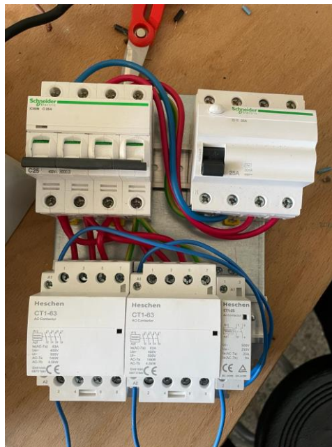
Figura 3-10: Instalación eléctrica para el conexionado de resistencias (autoría propia).
