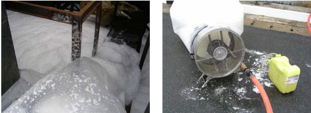
Figura 2-13 Aplicación de espuma de alta expansión con un Compact Excel. [7]
