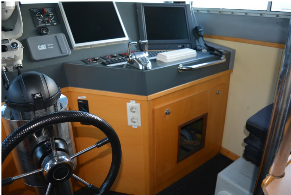
Figura A2-5 Armario de cableado.
