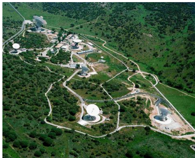
Figura 2-20 Fotografía aérea de la estación de Robledo de Chavela en 2014 (extraído de [20])
