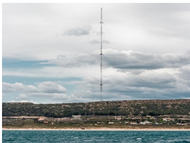
Figura 3-16 Fotografía de la antena de LF en Guardamar (extraído de [39])
