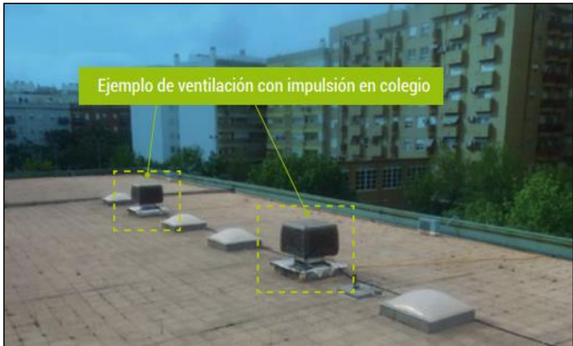
Figura 2-13 Ventilación con impulsión [35]
