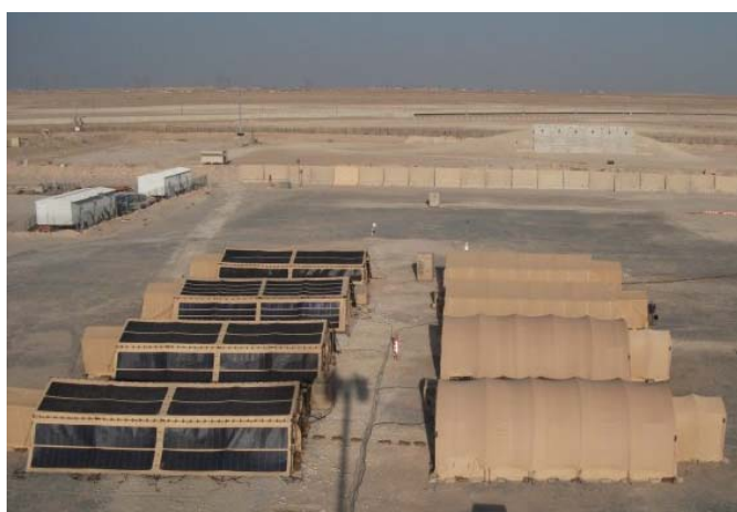
Figura 2-1 Tienda con paneles fotovoltaicos
