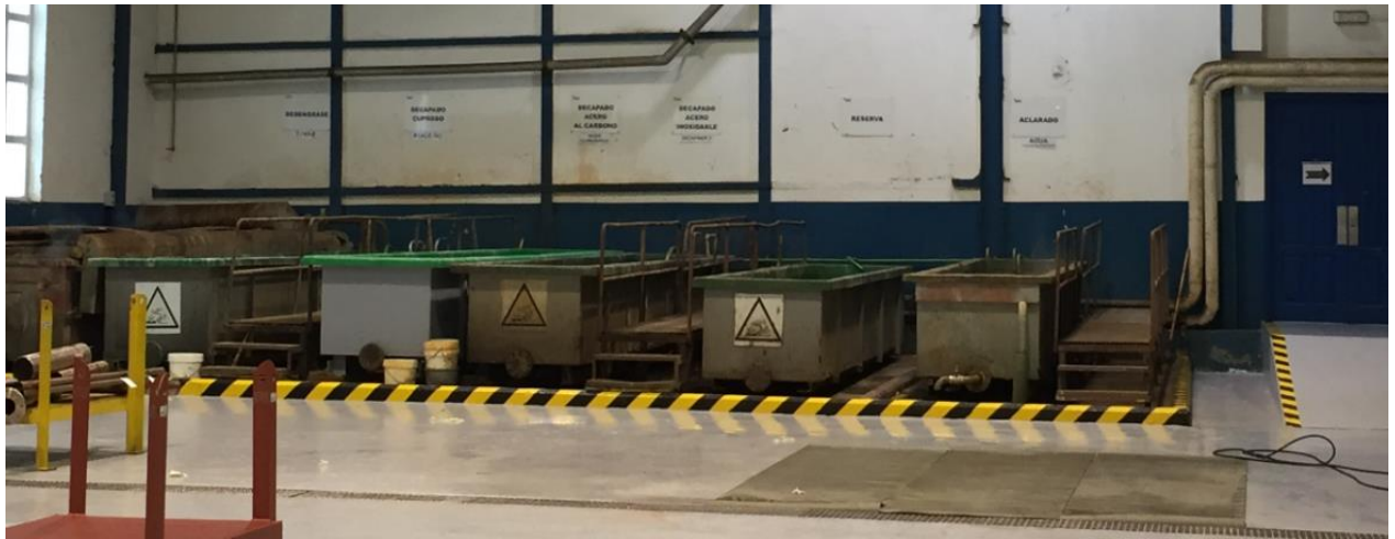
Figura 3-6 Zona de limpieza química.
