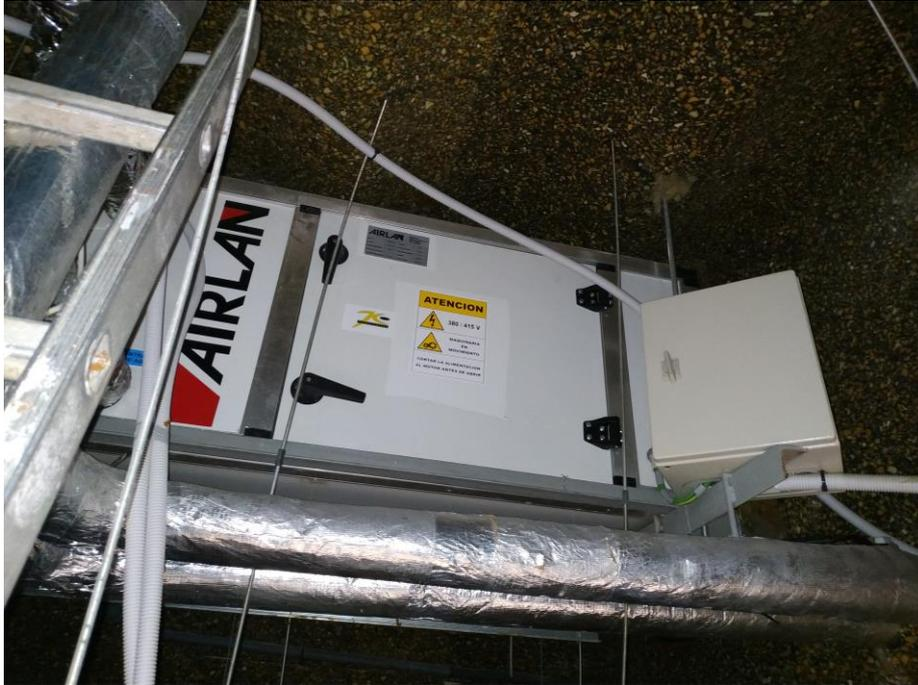
**Figura 3-7** Unidad de Tratamiento del Aire FMA/HP 036, instalada en el CUD
