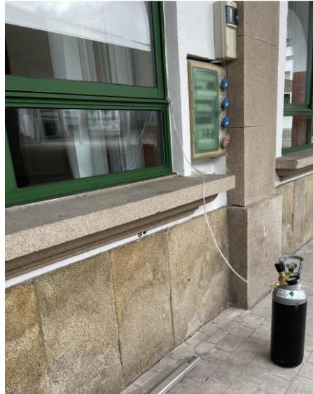
**Figura 3-43 Disposición para llenado de CO<sub>2</sub> desde el exterior del despacho**
