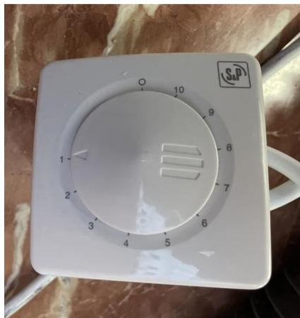
Figura 3-25 Regulador de velocidad del extractor
