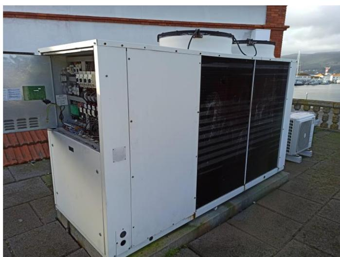
**Figura 3-16 Bomba de calor NRL 0650 H AR situada en la azotea del edificio del CUD**
