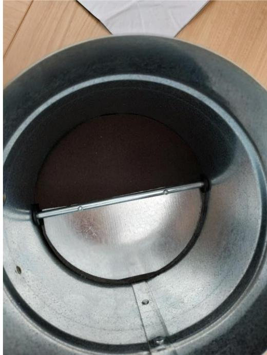
**Figura 3-12** Conducto de entrada del aire al falso techo, con la trampilla cerrada
