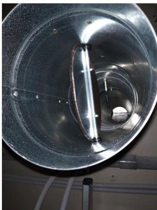
Figura 3-11 Conducto y trampilla abierta de entrada del aire al falso techo
