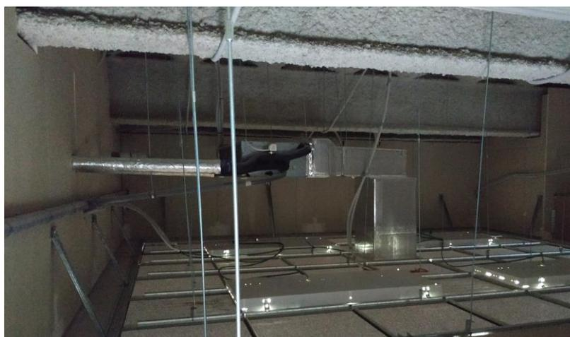
**Figura 3-18 Sistema fancoil y tuberías de refrigeración en el falso techo del despacho 114**
