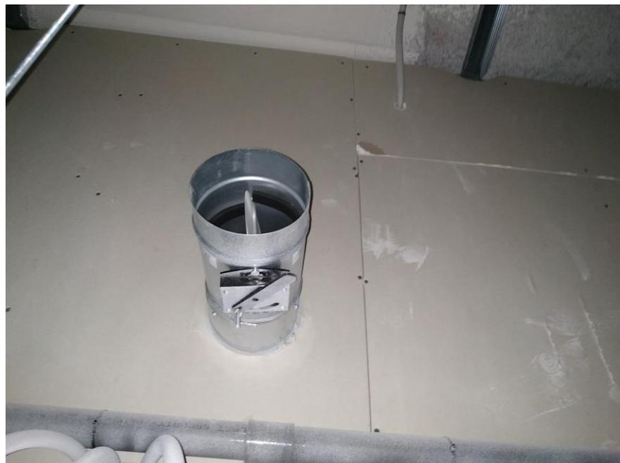
**Figura 3-13** Conducto de entrada de aire al falso techo
