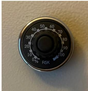
**Figura 3-8** Controlador del régimen de velocidad de la UTA
