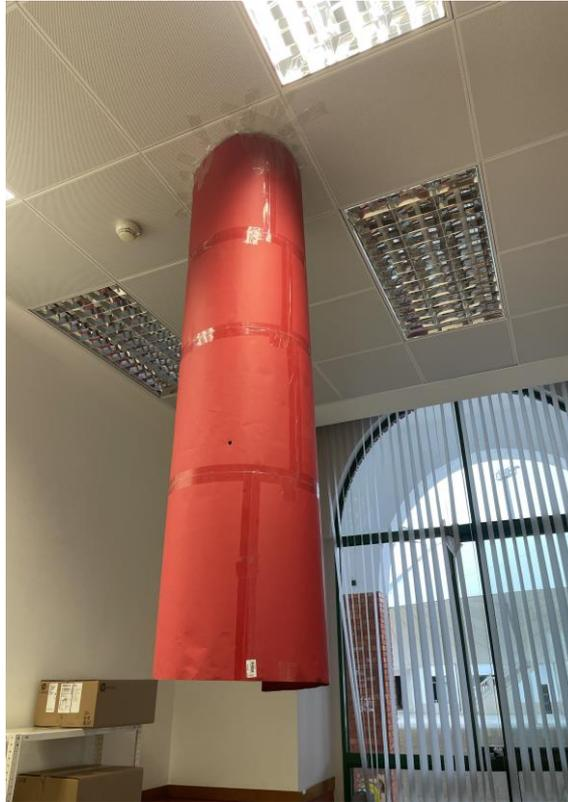
**Figura 3-35 Conducto de fancoil hecho de cartulina manualmente**
