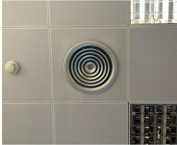
Figura 3-22 Difusor de fancoil en el techo del despacho 114
