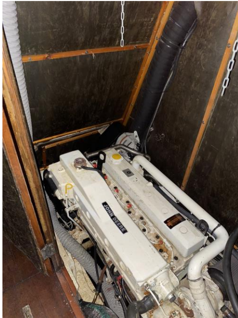
Figura 3-13 Compartimento de la cámara de máquinas
