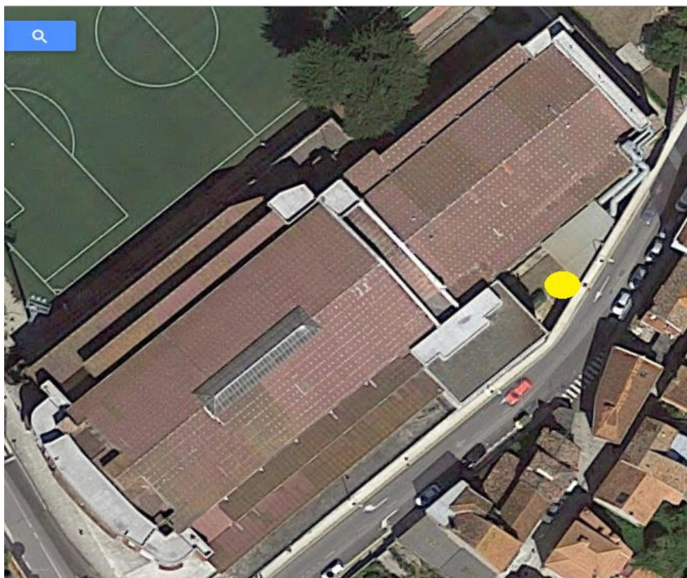
Figura 5-5: Ubicación del acumulador actual. Fuente: Google Maps.
