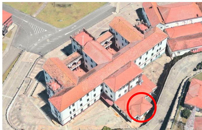
Figura 3-5 Sala de calderas del cuartel Marqués de la Victoria (Google Maps)
