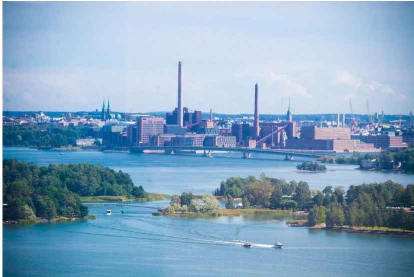
Figura 2-16 Central geotérmica en Finlandia de 40 MW, Espoo (Fuente: [57])
