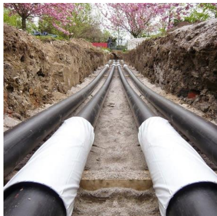
Figura 2-8 Sistema de cuatro tubos [30]
