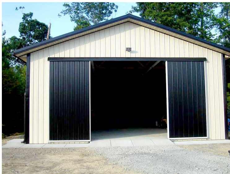
Figura 3-11 Nave metálica prefabricada [14]
