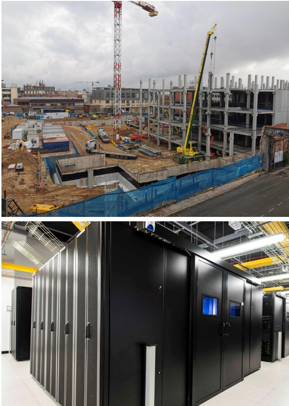
Figura 3-6 - Construcción del CPD de Interxion (Fuente: Interxion)
