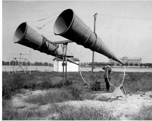
Figura 2-7 Sistema de detección de dos “bocinas” en Boiling Field, Estados Unidos, 1921 [1]
