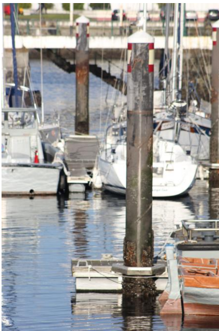
Figura 3-5 Detalle del pantalán anexo al muelle de Gelmírez.
