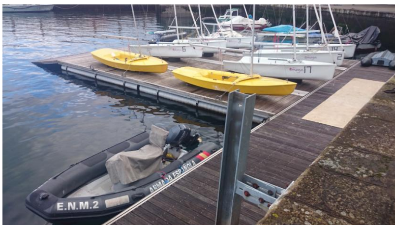
Figura 3-4 Pantalán actual con rampa y plataforma de varada.
