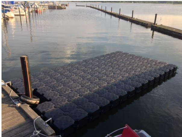
Figura 2-6 Pantalán flotante de matriz de elementos flotantes (tdocks.com)
