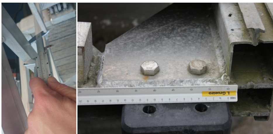
Figura 3-15 Mediciones realizadas en las instalaciones existentes.
