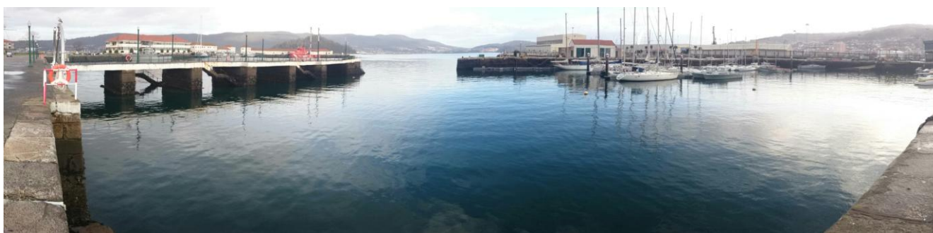
Figura 3-3 Vista general de la dársena formada por los muelles G.M.Chereguini y de Gelmírez.
