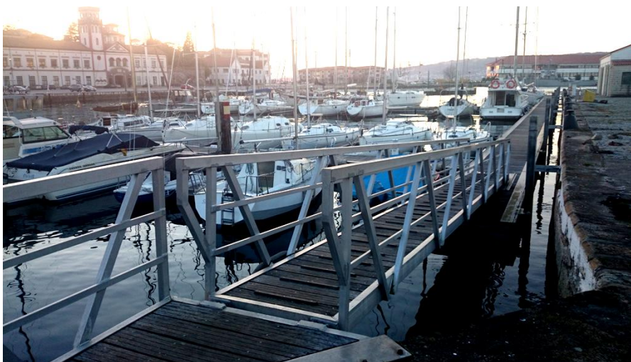
Figura 2-8 Pasarela y pantalanos de aluminio en la Escuela Naval Militar
