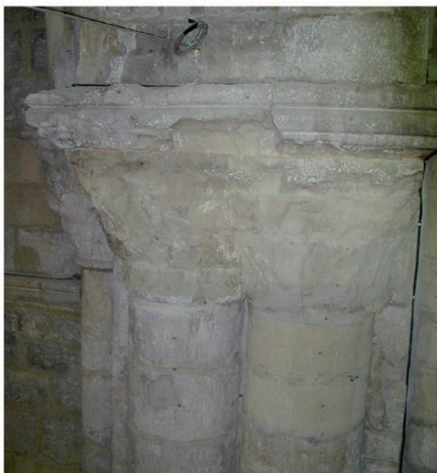
Figura 2-2 Imagen del proceso de Lixiviación en material de construcción. ( Imagen extraída de [14])
