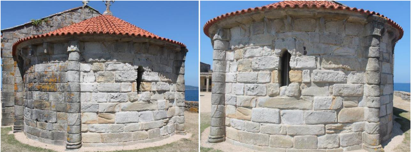
Figura 2-4 Arenización avanzada y alveolización en algunos sillares que conforman el ábside semicircular de la Capilla de Nuestra Señora de la Lanzada del siglo XII. (Imagen extraída de [18])
