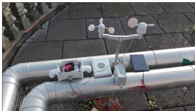
Figura 6-3: Primera colocación de la estación meteorológica
