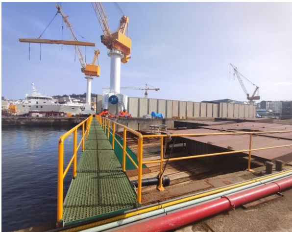
Imagen 18. Dique seco y entorno portuario equipado con grúas de gran capacidad.
