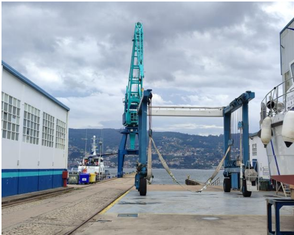
Imagen 16. Pórtico de varada y zona de transferencia de embarcaciones al agua en Astillero Armón.
