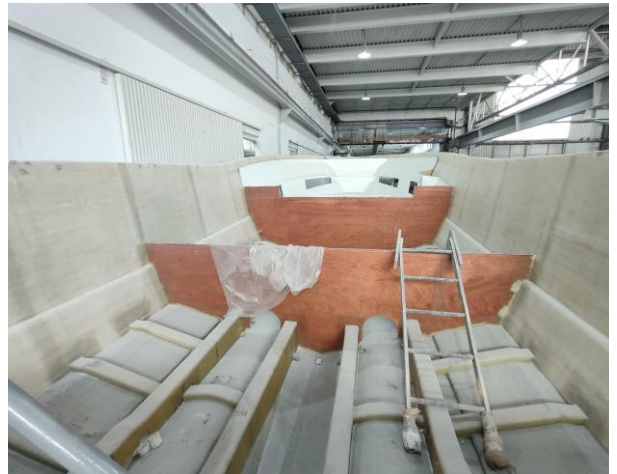
Imagen 6. Interior de buque de PRFV con configuración de refuerzos estructurales.
