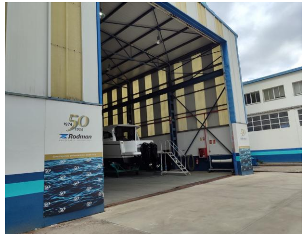
Imagen 12. Acceso a la nave principal del astillero Rodman.
