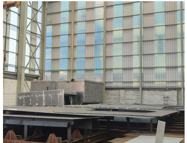
Imagen 19. Taller o área de acopio y prefabricación de chapas de acero.
