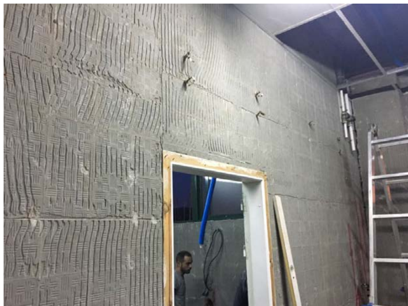
Figura 3-49 Tabique con capa de material de agarre
