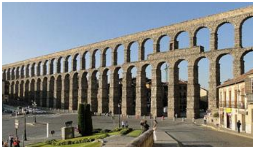
Figura 2-1 Acueducto de Segovia [11]
