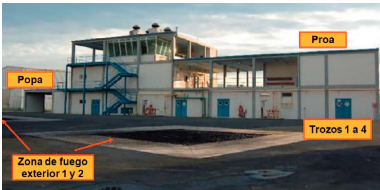
Figura 2-17 Vista frontal del adiestrador de contraincendios [6]
