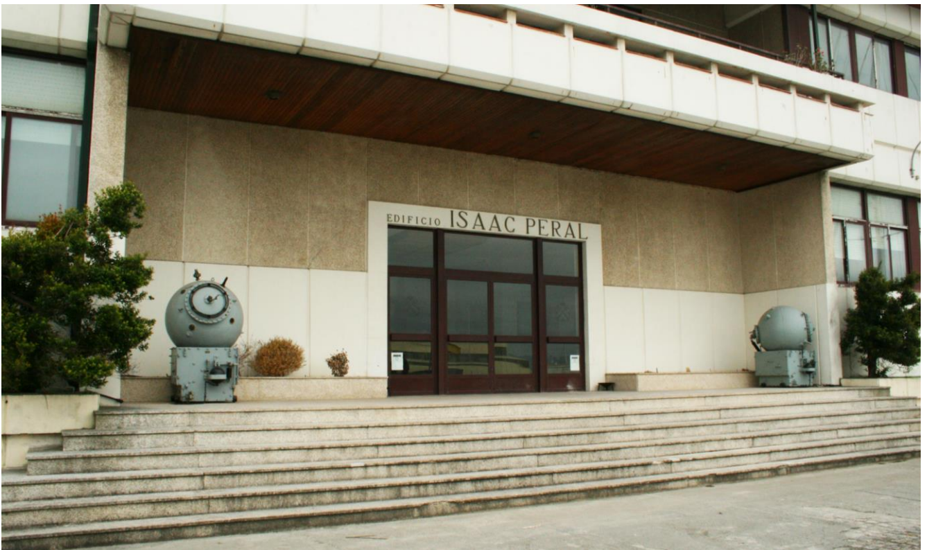
Figura 3-1 Entrada del edificio Isaac Peral de la ENM. (Fuente: [36])
