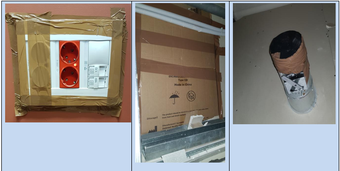
Figura 3-6 Sellado de filtraciones y cierre del conducto de ventilación
