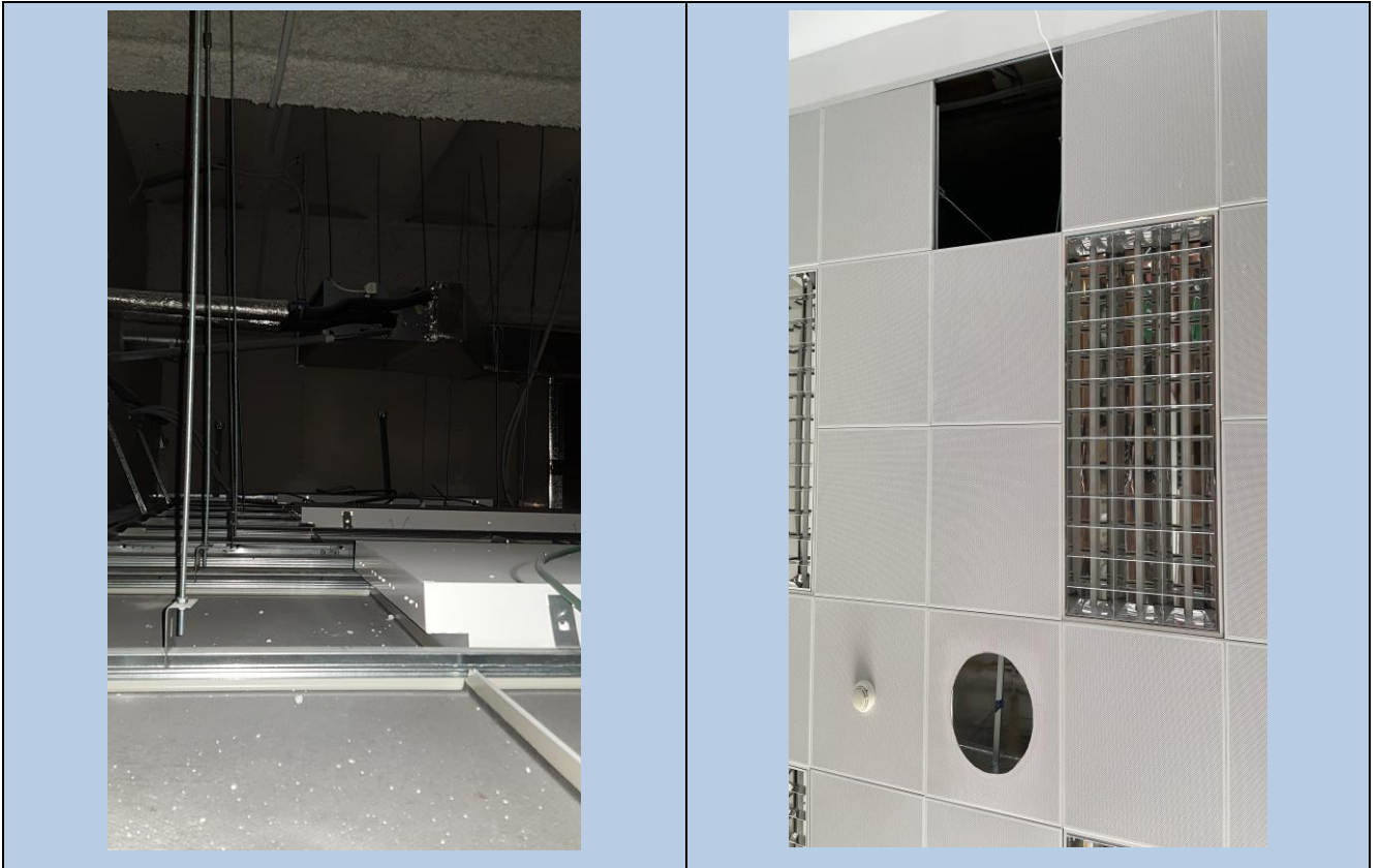
Figura 3-3 Falso techo de despacho 114 (vista interior y exterior)
