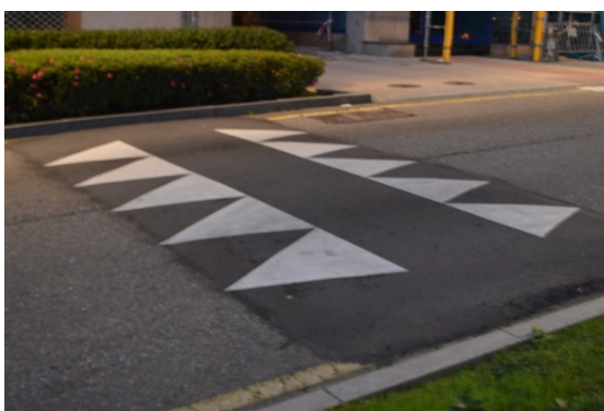
Figura 1-7 Ejemplo de badén de lomo de asno in situ
