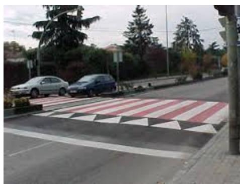
Figura 1-5 Fotografía badén de paso peatonal
