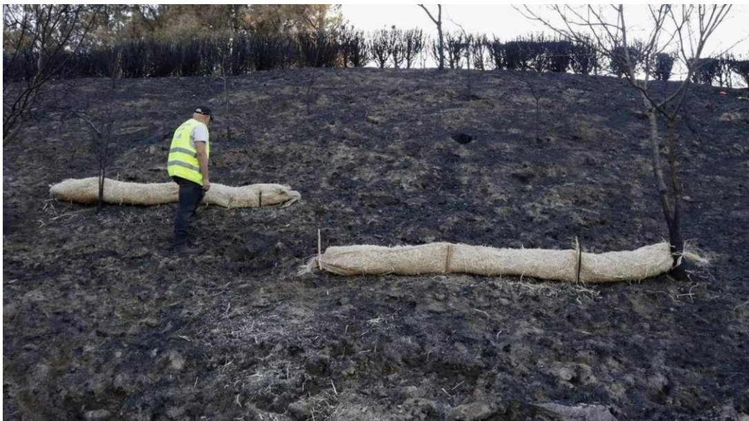
Figura 2-6 Barreras de tela biodegradable para prevenir la erosión del suelo [36]
