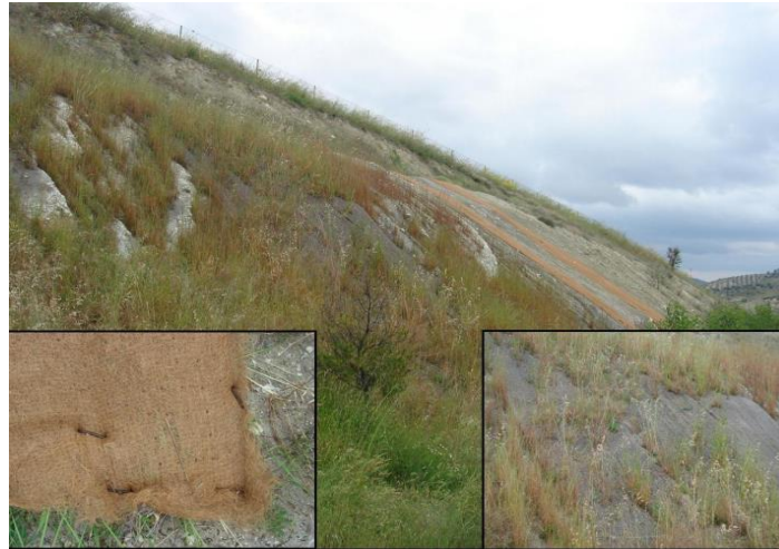
Figura 2-7 Talud tratado con matas orgánicas e hidrosiembra [40]
