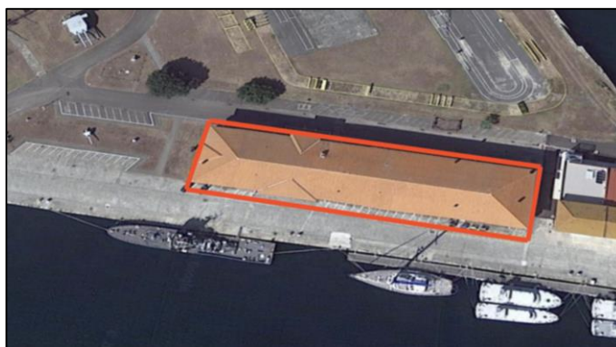
Figura 4-3 Vista aérea Edificio Isaac Peral (Autoría propia)
