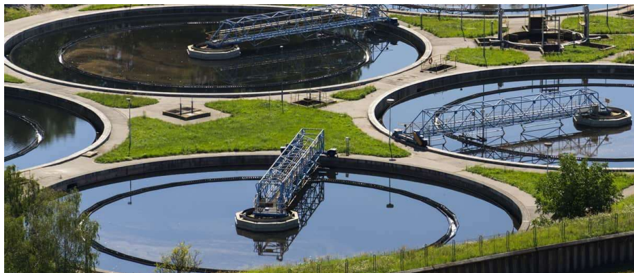
Figura 3-8 Planta de tratamiento biológico de aguas residuales con decantadores circulares [15]
