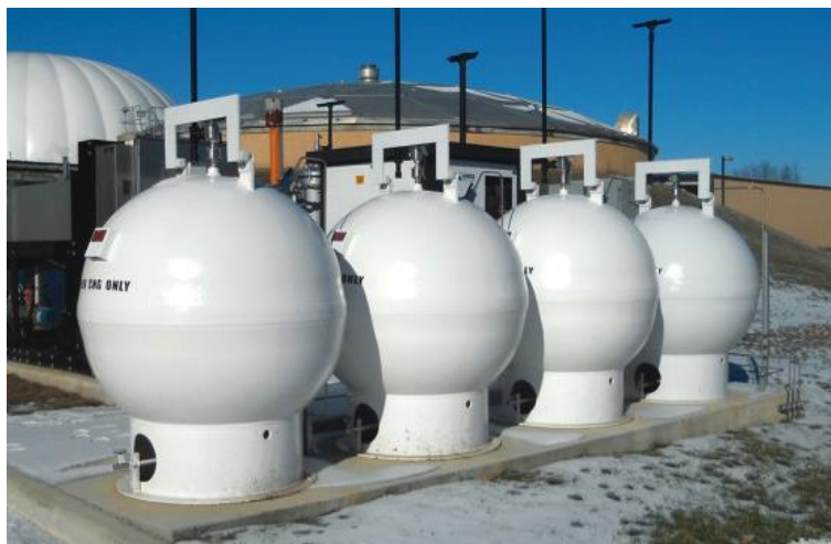
Figura 3-5 Depósitos esféricos de GNC a 300 bar [50].
