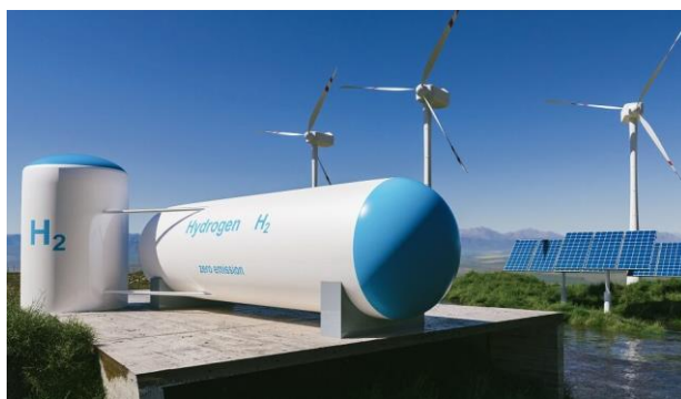
Figura 1-1 Almacenamiento Hidrógeno verde [2].
