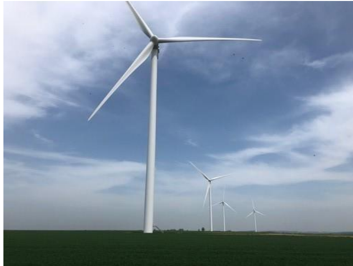
Figura 4-7 Vestas V112 instalado en un campo eólico terrestre. Fuente: [50].
