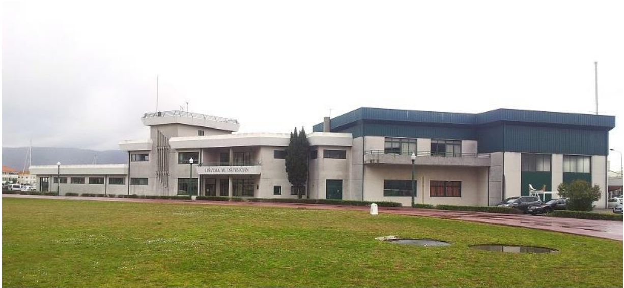
Figura 1-1 Edificio Príncipe de Asturias
