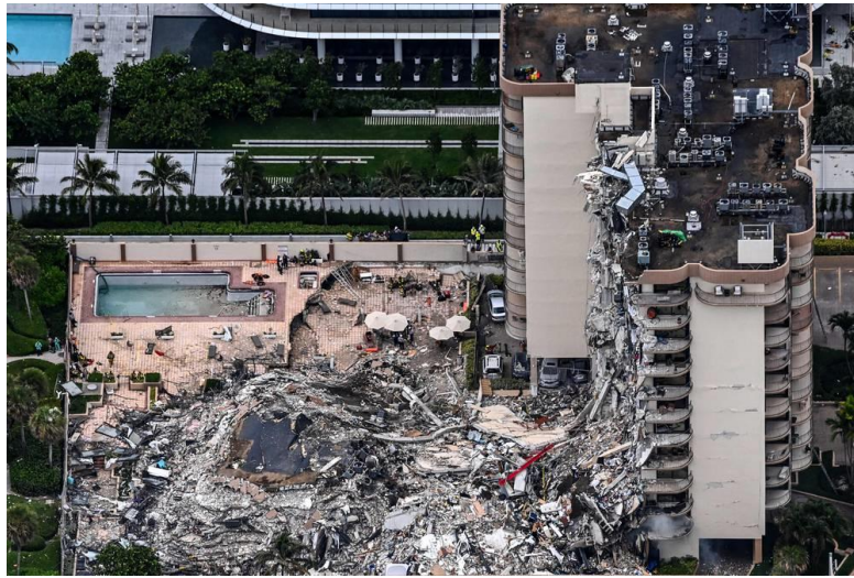
Figura 2-3. Fotografía del colapso sufrido por un edificio en Florida. Entre las causas del derrumbe los expertos indican que se encuentra la exposición prolongada a la sal marina y al aporte continuo de sales que favorecieron los procesos de corrosión de las armaduras. Imagen AFP [8]
