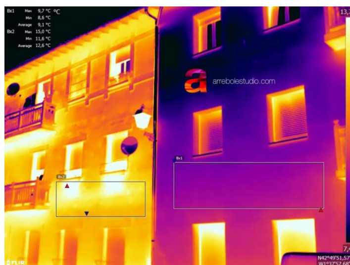
Figura 2-10. Termografía cuantitativa de fachadas. Izquierda sin reformar, derecha reformada [30]
