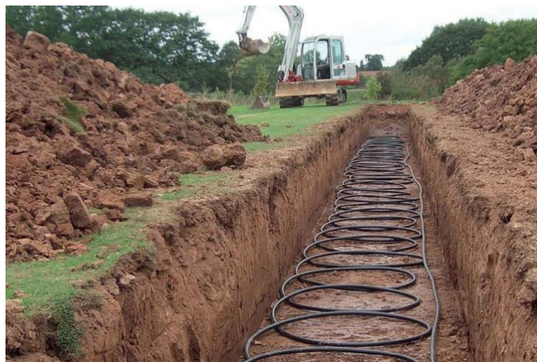
Figura 2-6 Ejemplo de captador horizontal tipo Slinky. (Fuente: [24])
