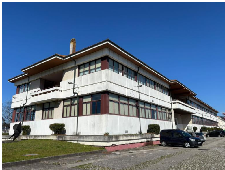
Figura 3-2 Edificio Isaac Peral
