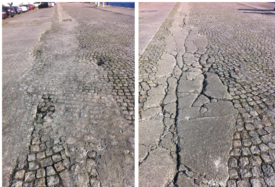
Figura 4-3: Estado de la zona de 0 a 100 metros de distancia
