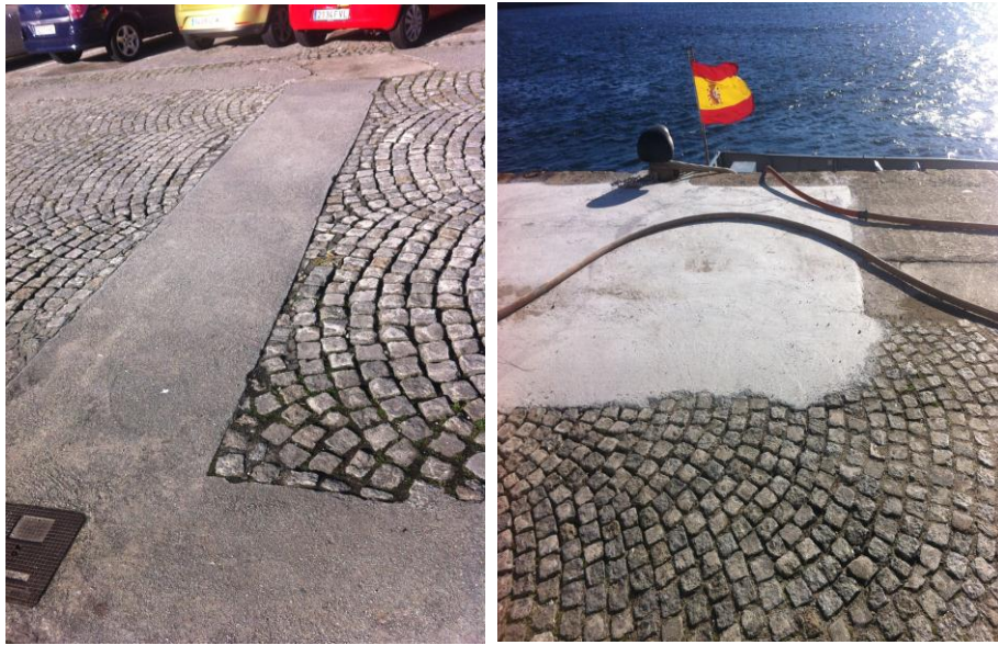
Figura 4-8: Tubería y bloque de hormigón mencionados anteriormente.
