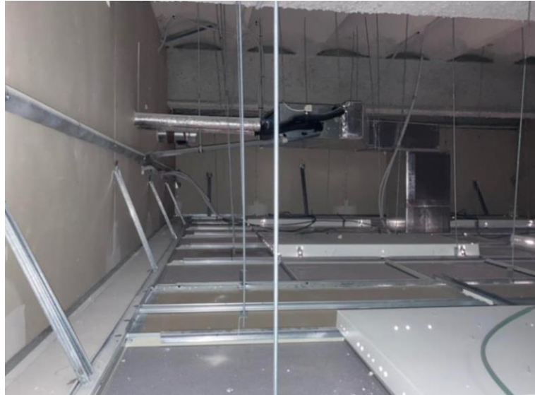
Figura 3-8 Instalación del fancoil en el falso techo
