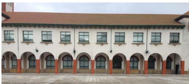
Figura 3-3 Vista de la cara sur del edificio desde el patio de aulas
