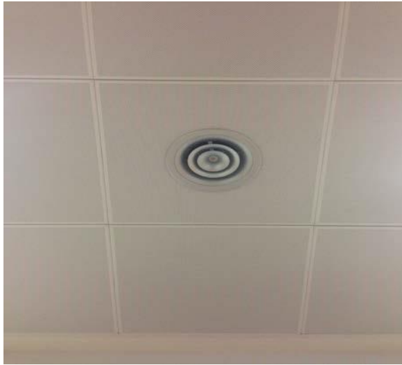
Figura 3-10 Difusor de aire del modelo TROX ADLR-Q AEMEC de las estancias
