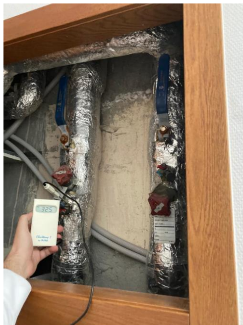
Figura 3-30 Imagen midiendo la temperatura de las tuberías de la bomba de calor
