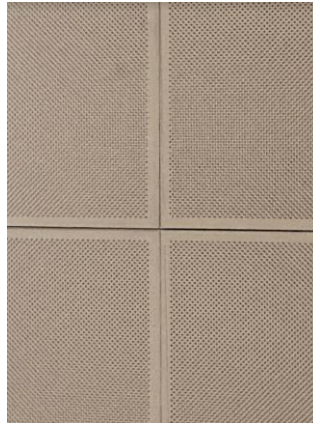
Figura 3-14 Techo de bandeja de módena microperforado de las estancias y pasillos del edificio
