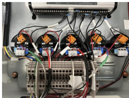
Figura 3-10 Transmisores / conversores de temperatura Pt-100 (elaboración propia).
