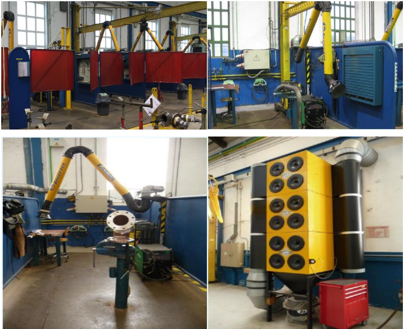
Figura 3-22 Puestos de soldadura
